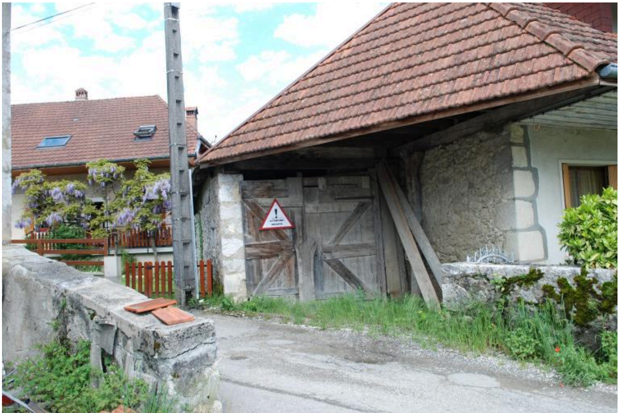
Détail ouest de la façade principale.
