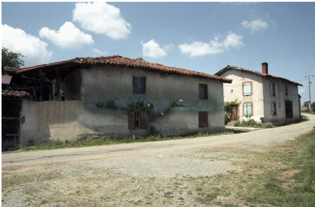
Marcoux, Goutterelle (1986 ZE 37), type A2. Vue d'ensemble de la ferme originelle et du logis actuel, depuis la route.
