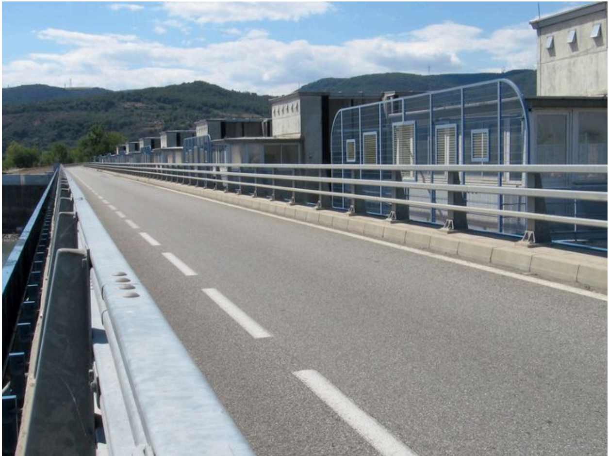
Chaussée du pont aval (depuis la rive gauche)
