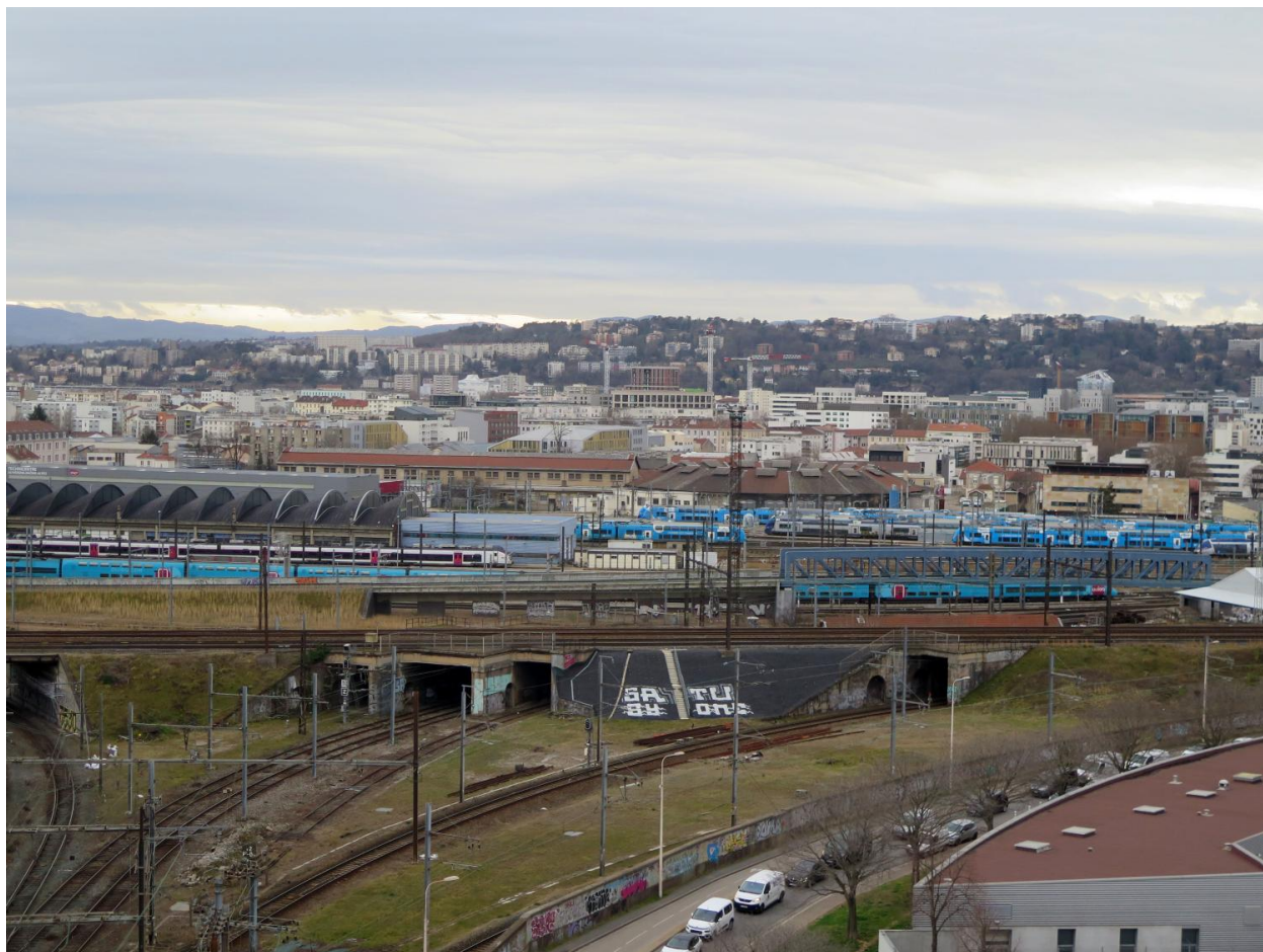
Vue d'ensemble voies ferrées et rotonde
