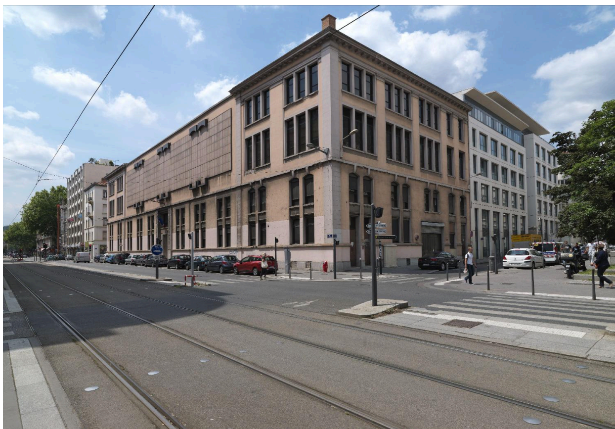
Façade principale des Archives départementales du Rhône
