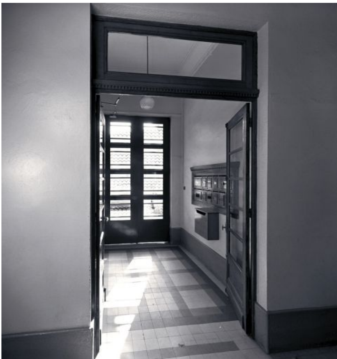
Vue d'ensemble du vestibule
