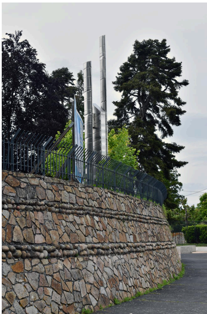
Vue depuis l'extérieur et depuis le sud
