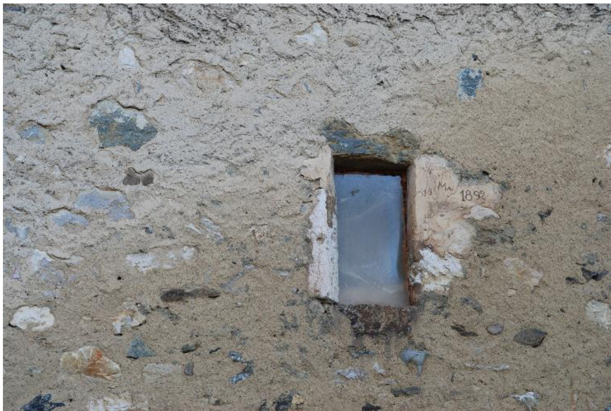
Détail d'une baie de la façade nord.
