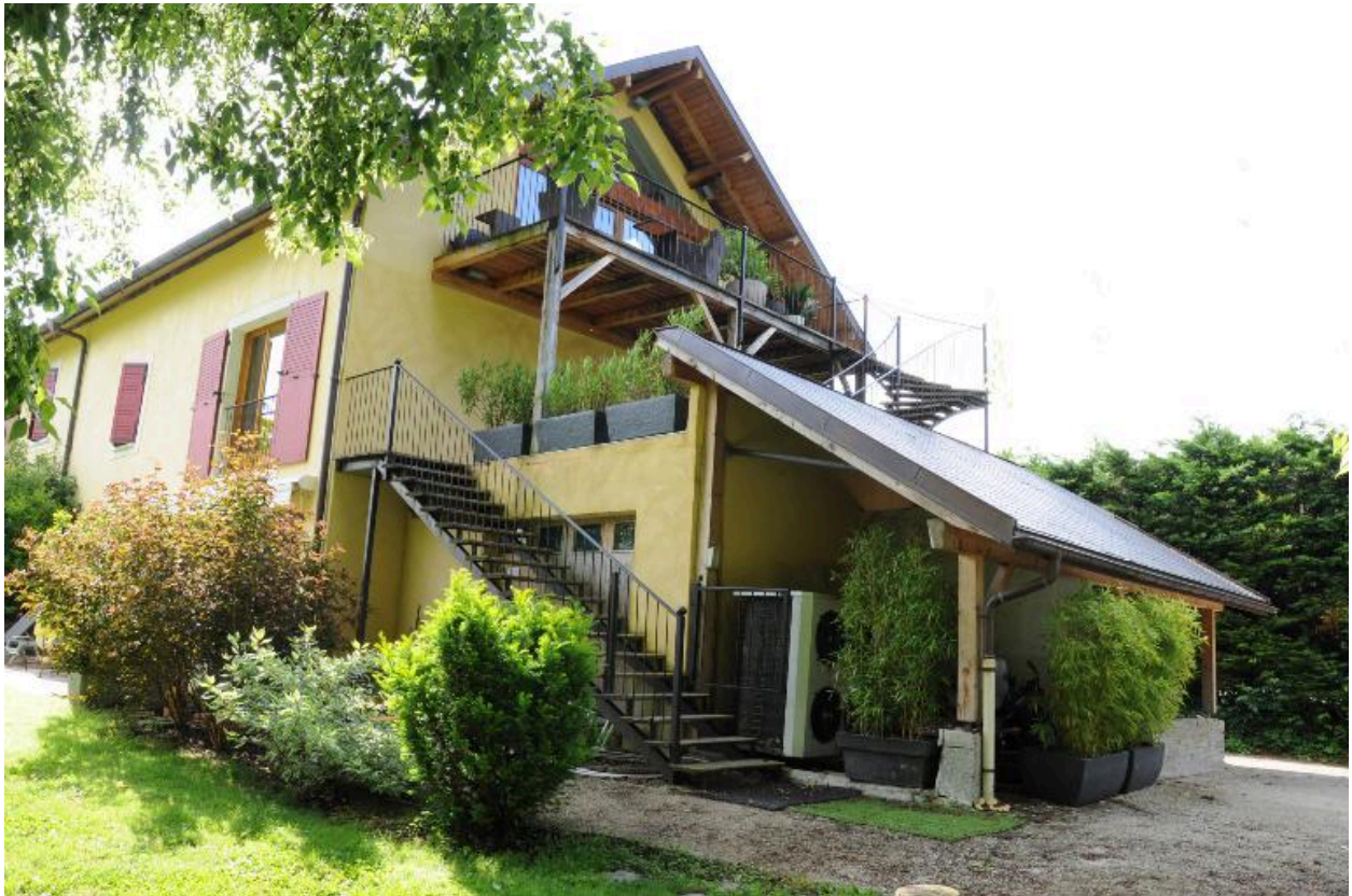
Détail du pignon ouest
