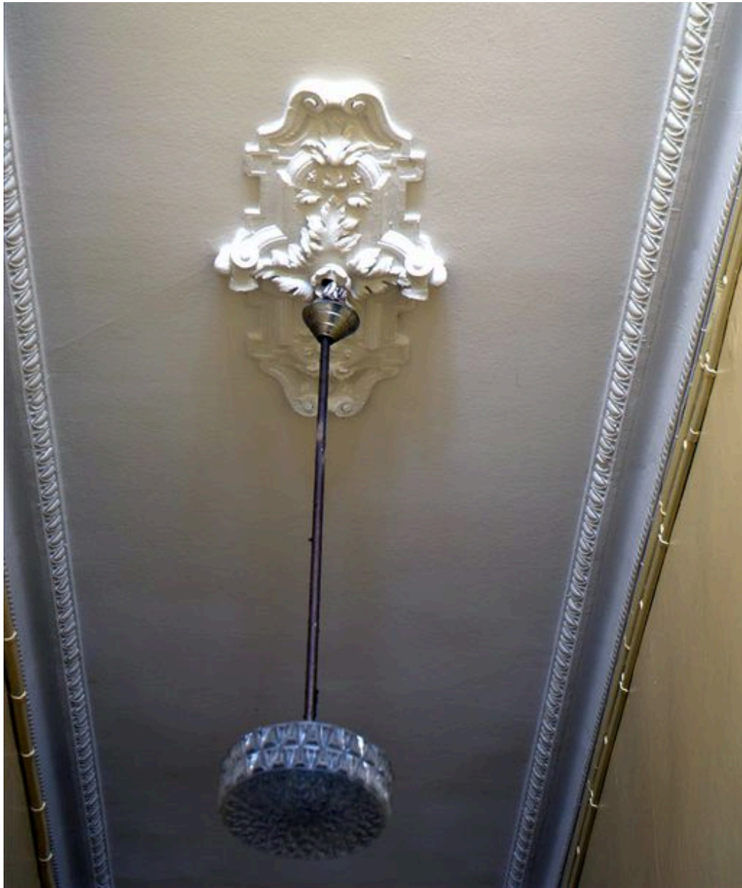
Allée, détail du plafond
