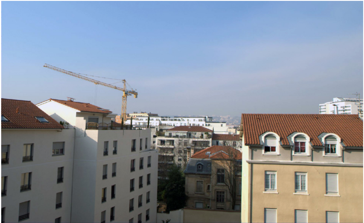
Élévation principale, détail de l'angle sud-ouest
