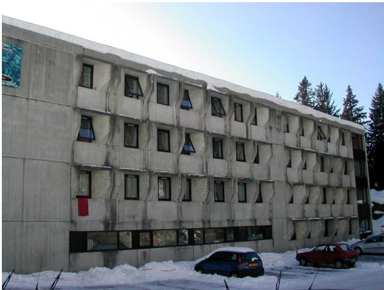
Etat avant réfection. Façade nord
