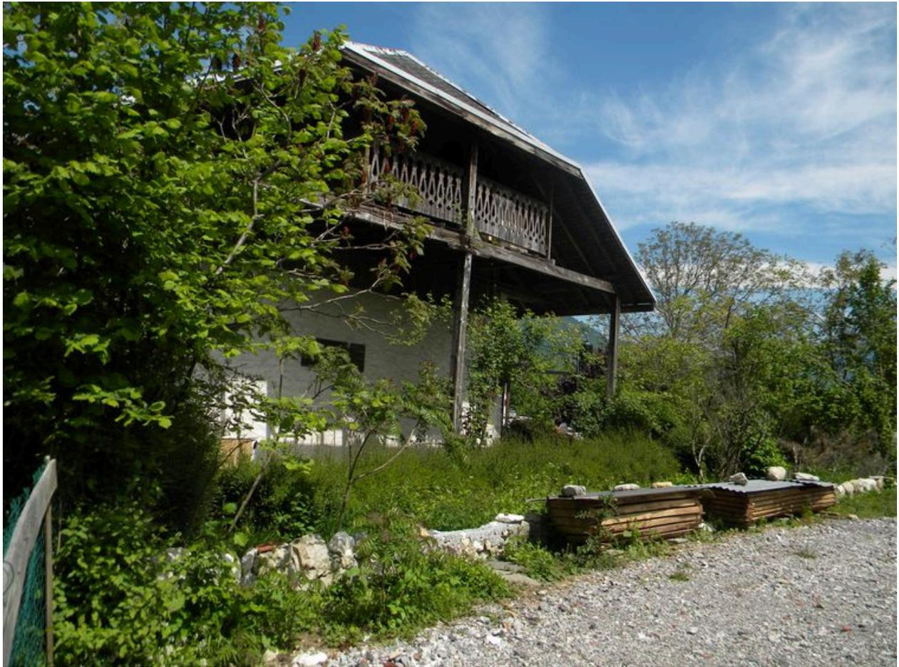
Avancée de toiture sous demi-croupe avec espace de séchage d'une ancienne ferme (2008 C8 2123).
