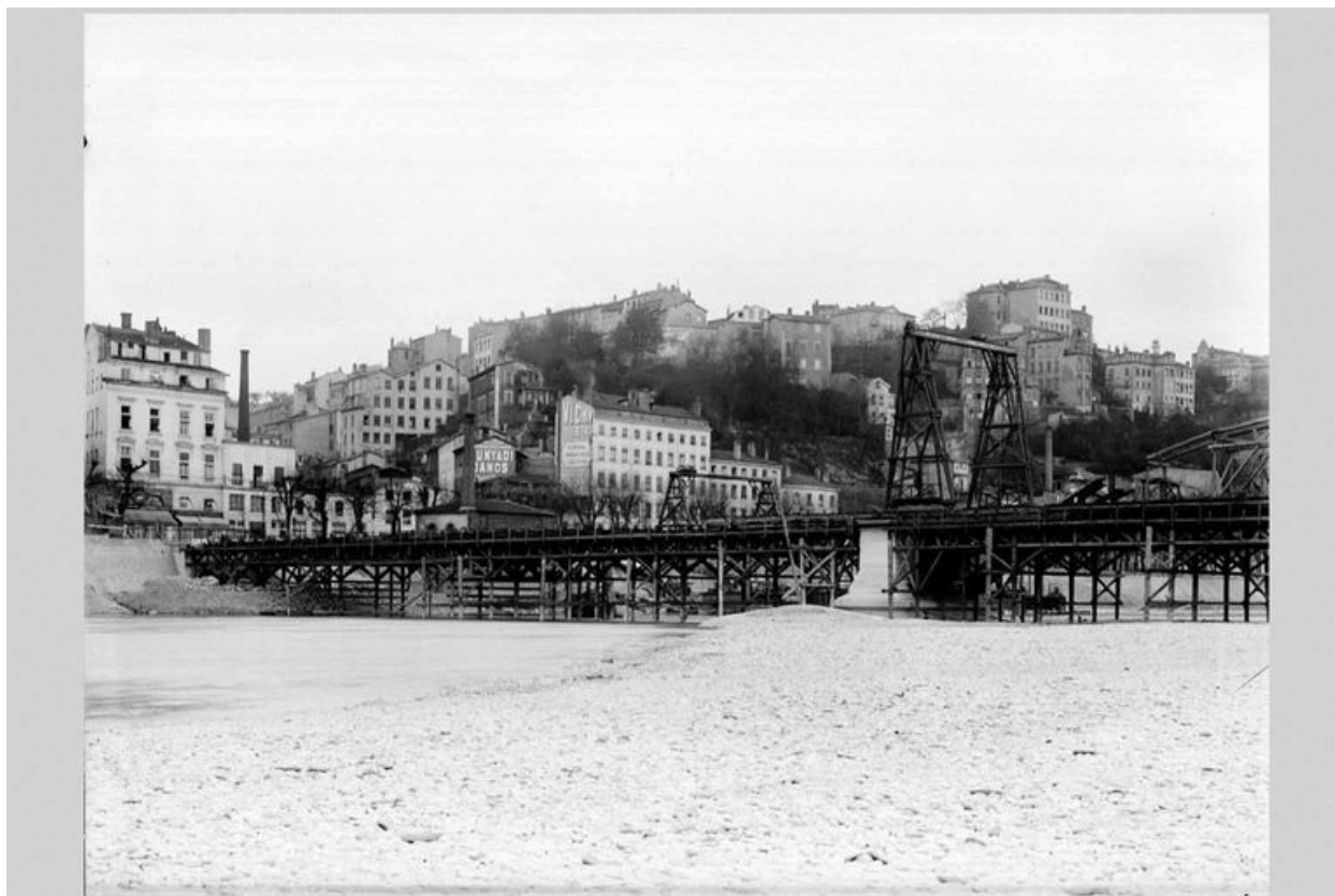
La construction du pont de la Boucle. Vue d'ensemble du tablier et des pieux le soutenant. Photogr., [1903] (Arch. mun. Lyon. 15 Ph 1821)
