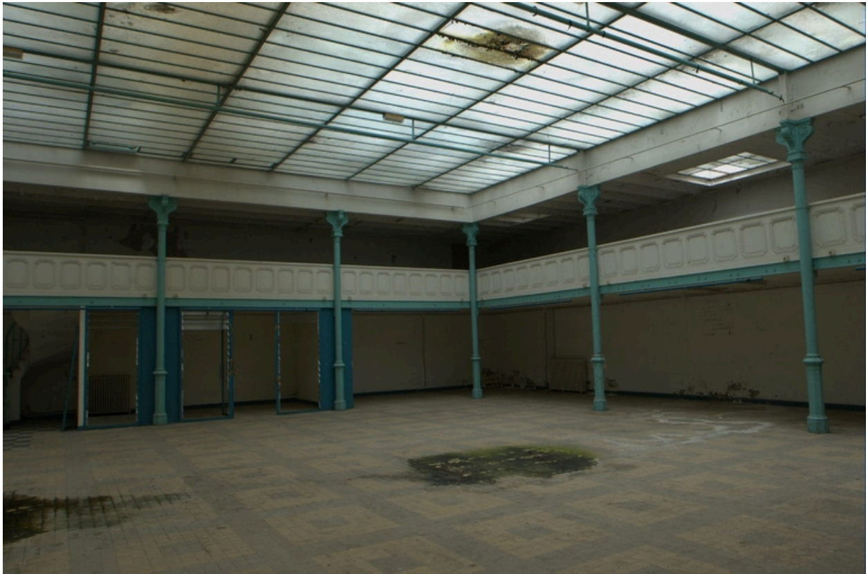
Vue d'ensemble de la halle couverte
