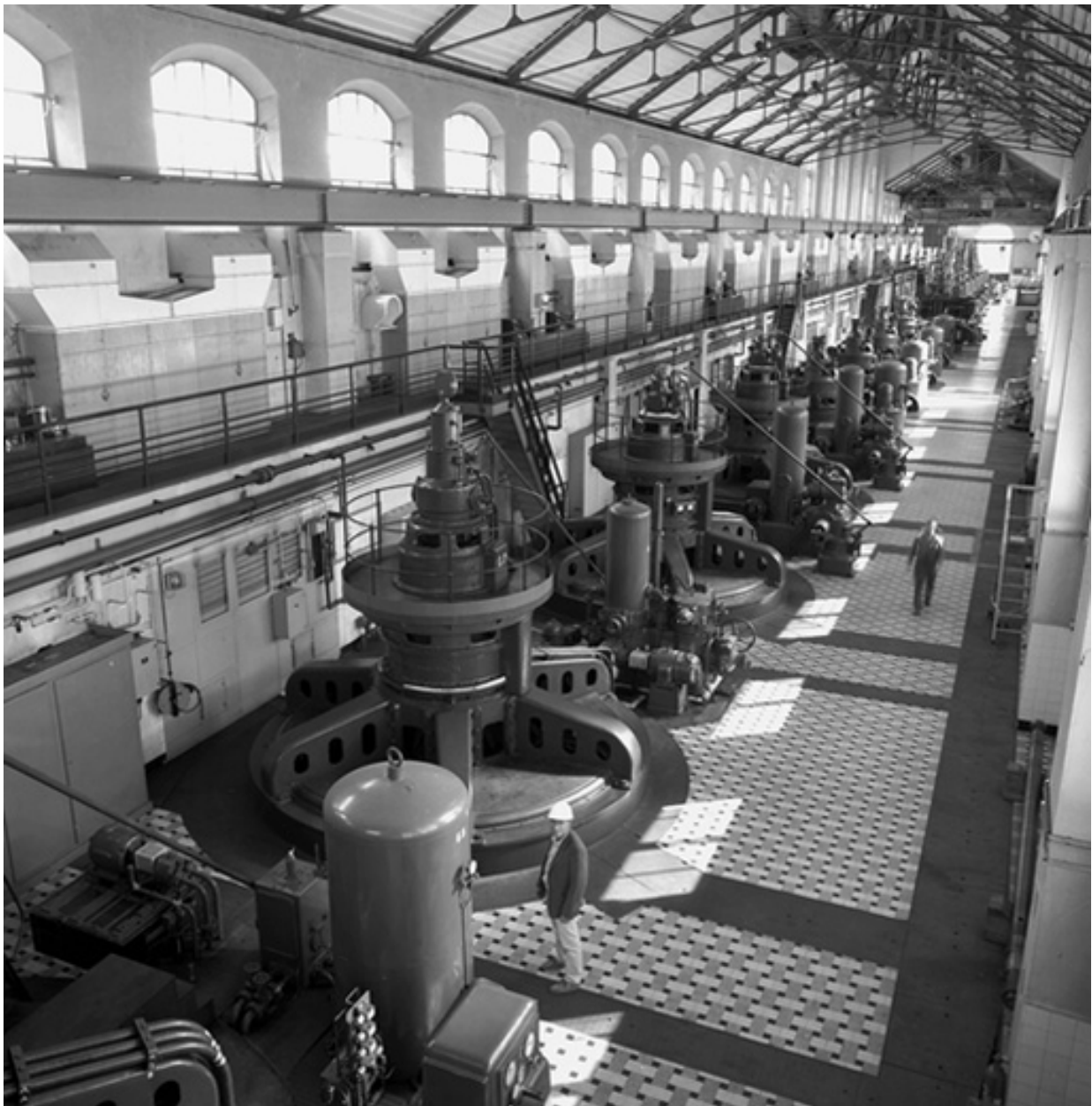
Vue d'ensemble sud-est
