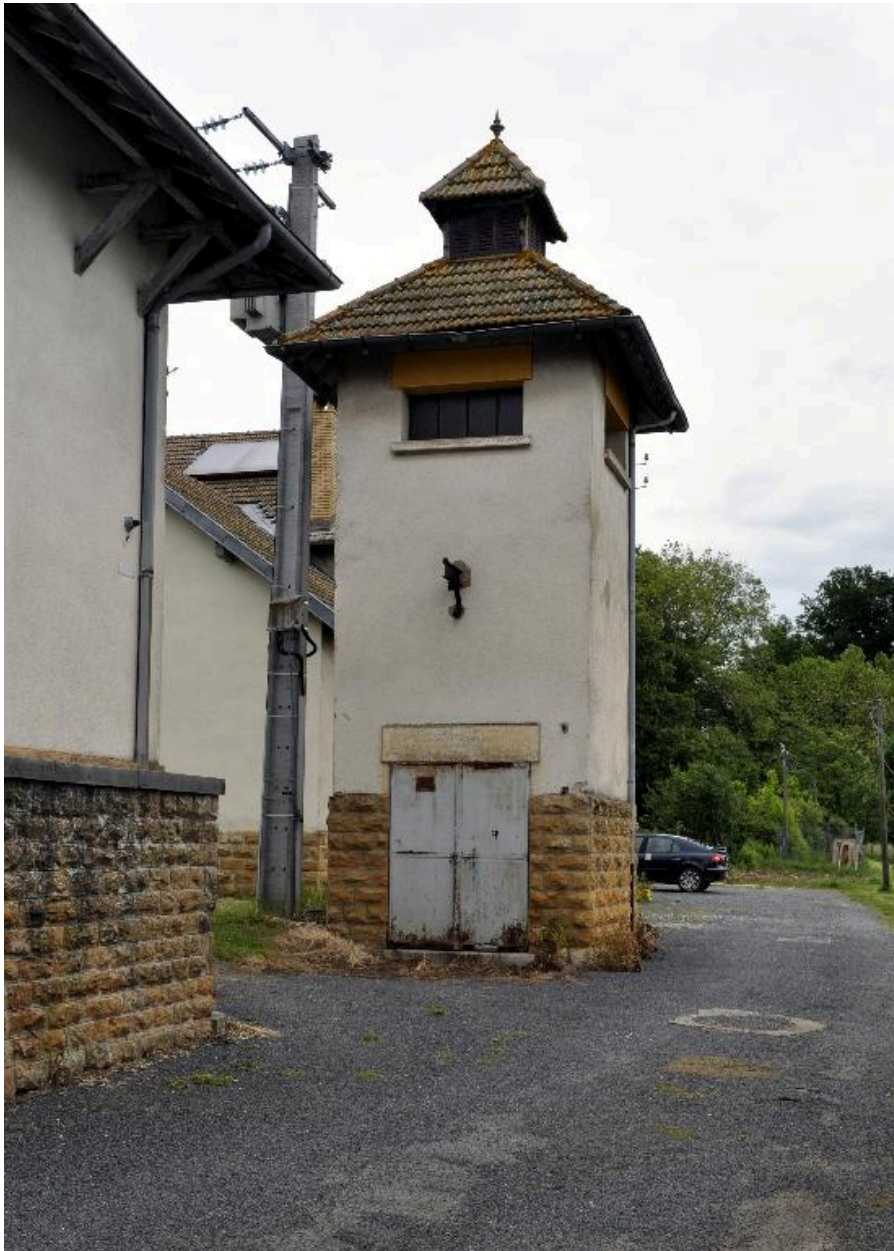
Ferme-école : poste de transformation
