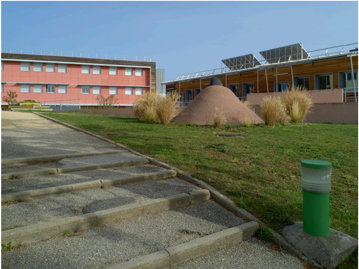
Vue générale, dans son environnement.
