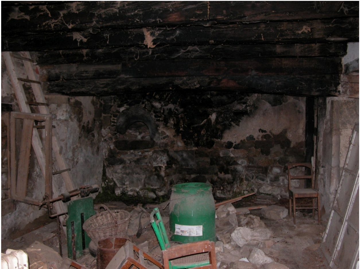
Vue intérieure du logis : cheminée au large.
