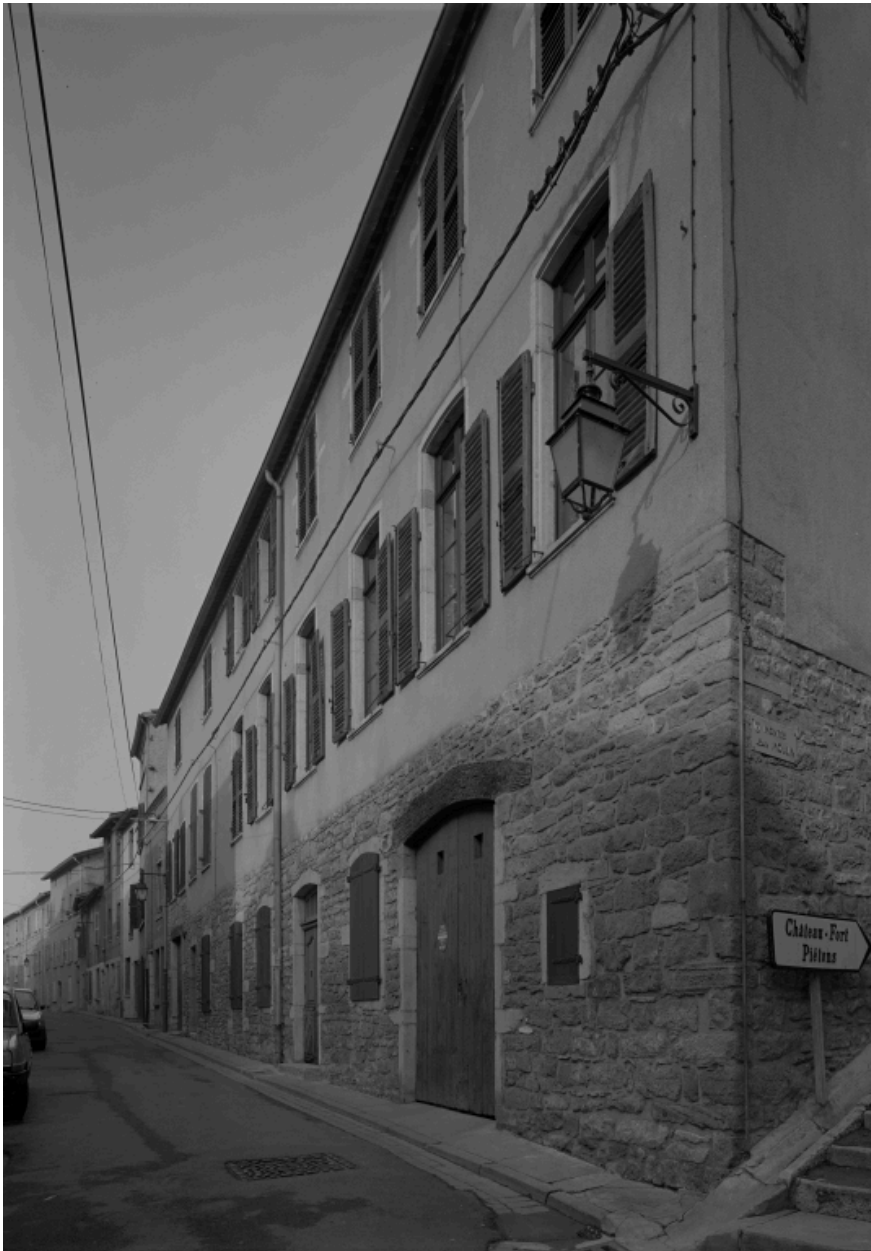
Maison urbaine de type VII, 6 rue Montsec : élévation à travées, mais non symétrique, porte cochère latérale, jardin en contrehaut à l'arrière (construite vers 1770).
