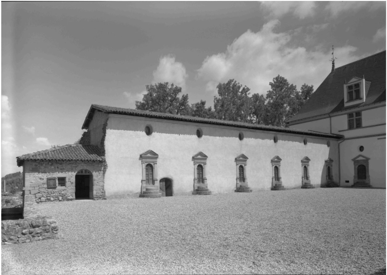
Vue générale de la façade sur cour du corps dit de garde, de l'ouest.
