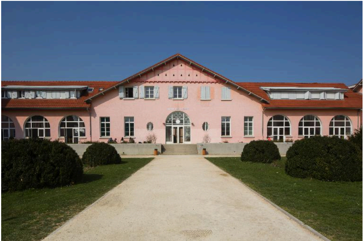
Bât. A : corps central et allée principale
