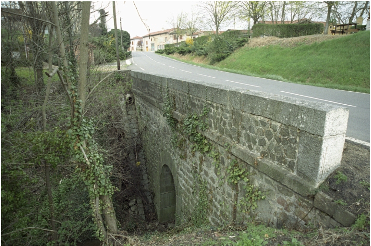
Vue du pont sur le CD 8 au lieu-dit Chez Meynet.
