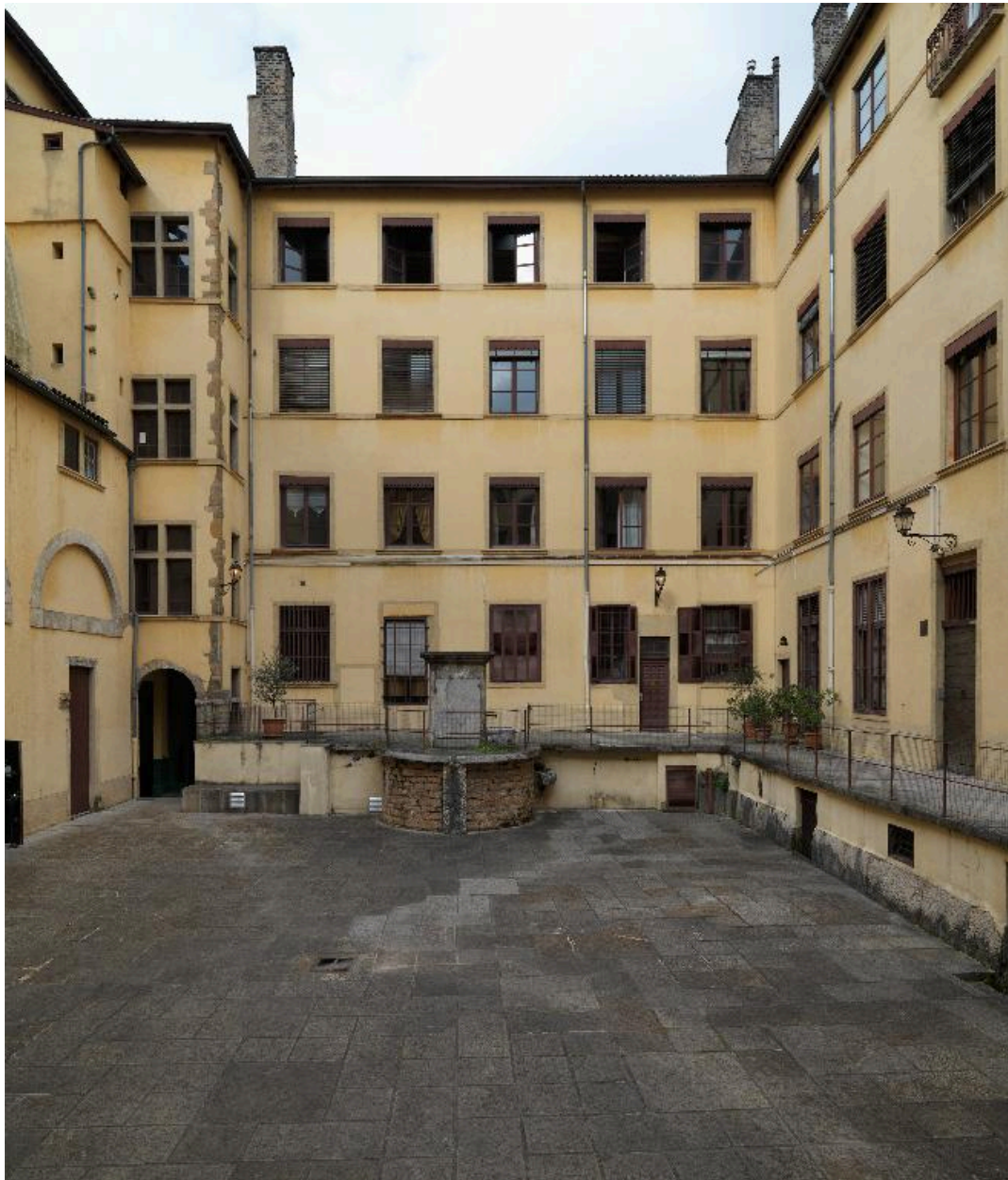
La cour : vue vers l'ouest
