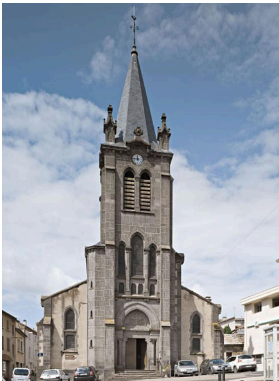
Vue générale de la façade occidentale.
