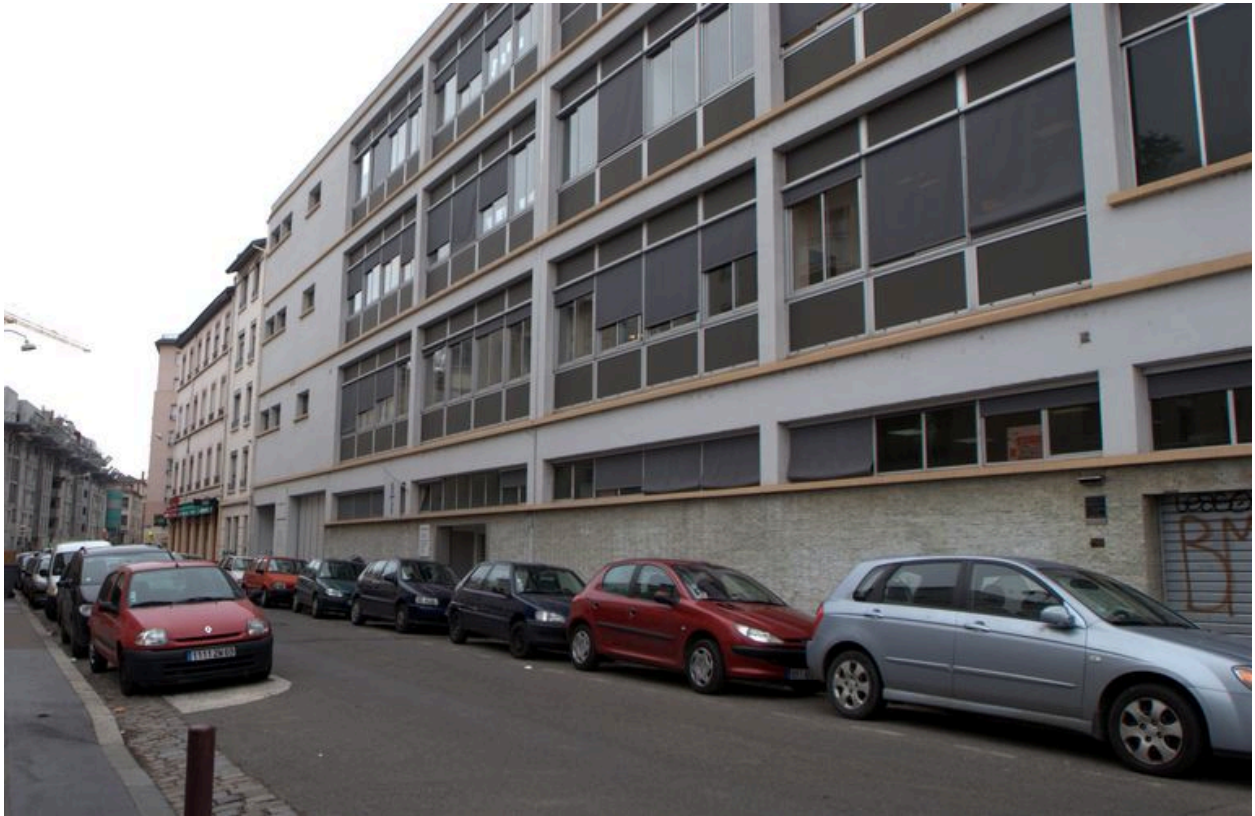
Élévation antérieure depuis le sud
