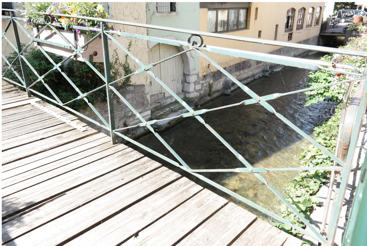
Passerelle des Cordeliers, détail des garde-corps
