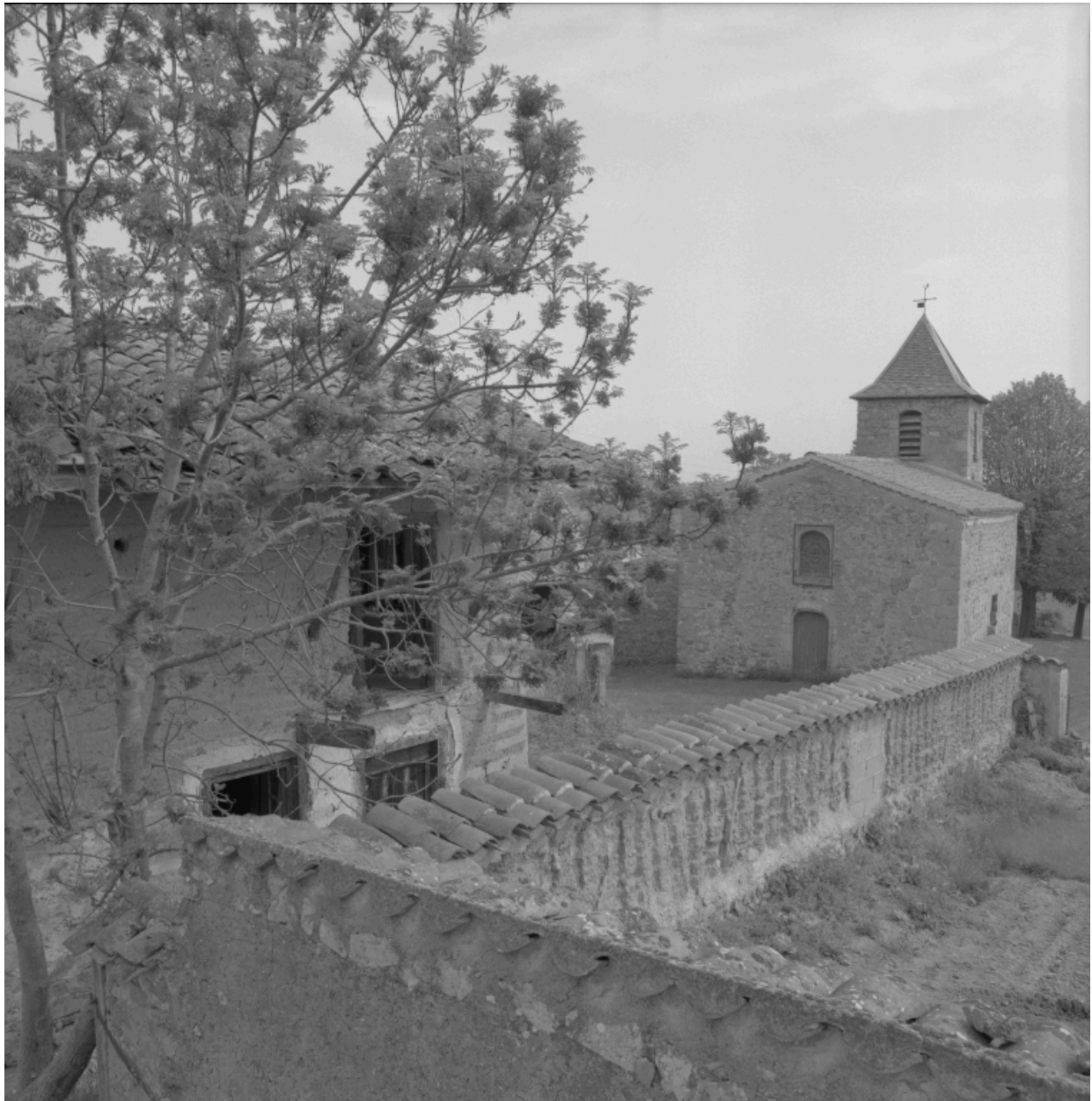
Vue générale depuis le sud-ouest.
