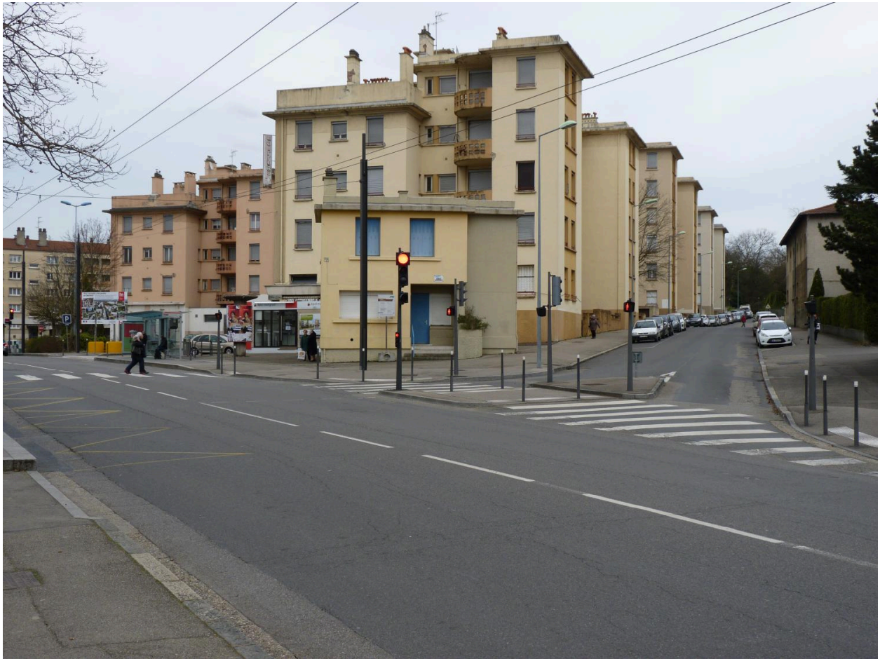
Vue d'ensemble de la cité Montessuy avant démolition
