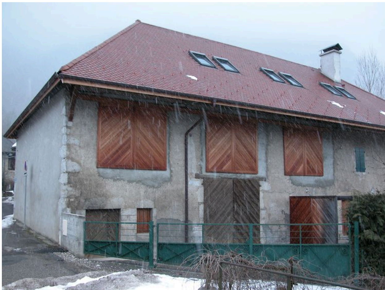
Vue de la façade sud-ouest avec ouvertures de fenil reprises en bardage.
