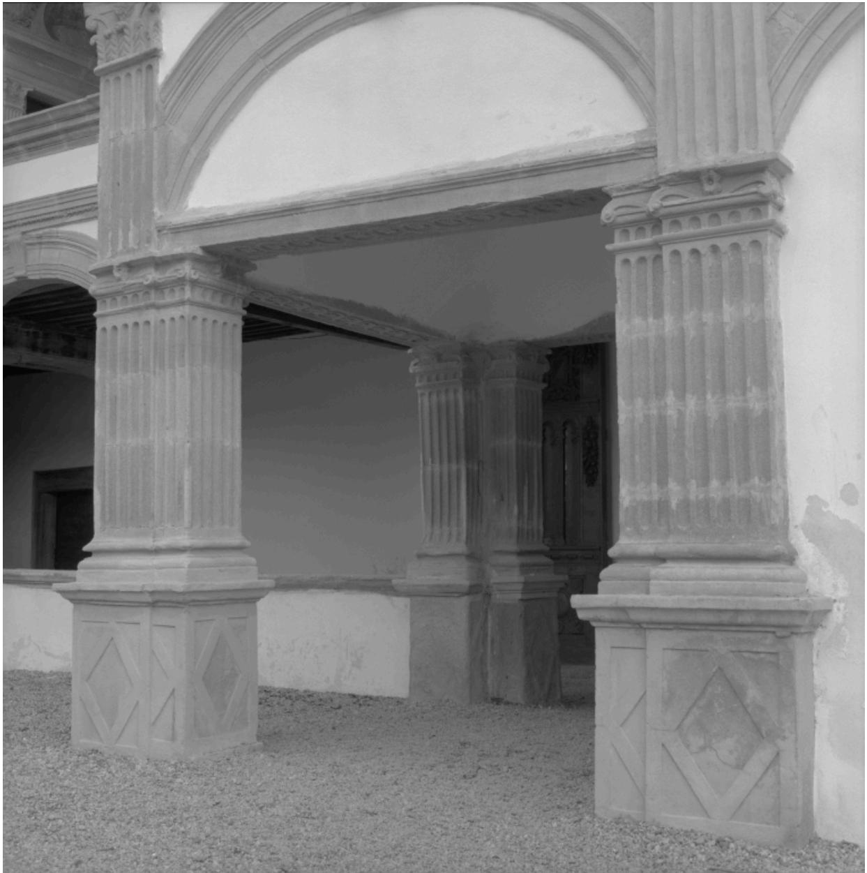
Corps de galerie, pavillon formant saillie : détail des pilastres.
