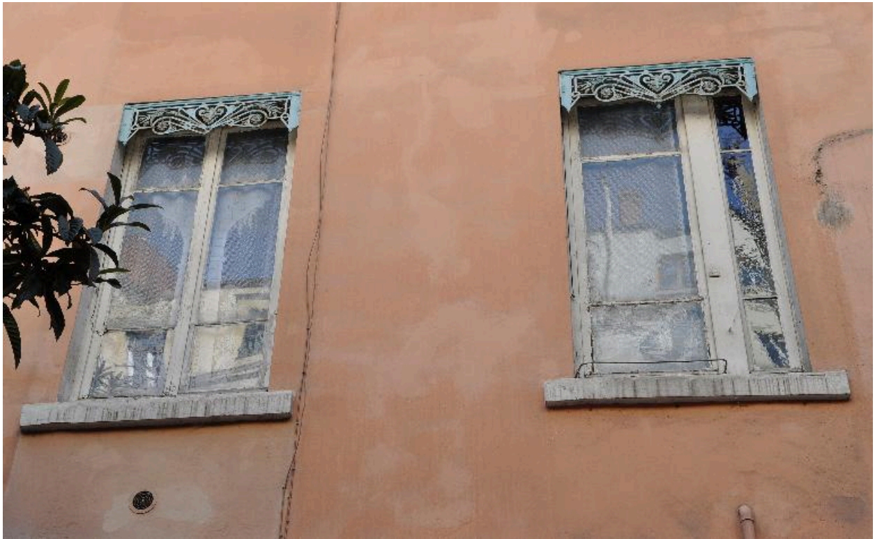
Immeuble sur rue rue, vue rapprochée de l'élévation sur cour
