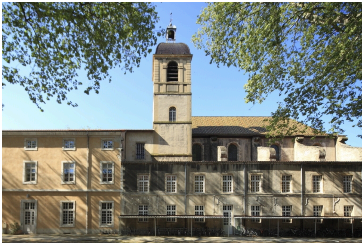
Bâtiment C. Cour intérieure sud. Façades orientales de l'église, de l'aile 17e, du clocher.
