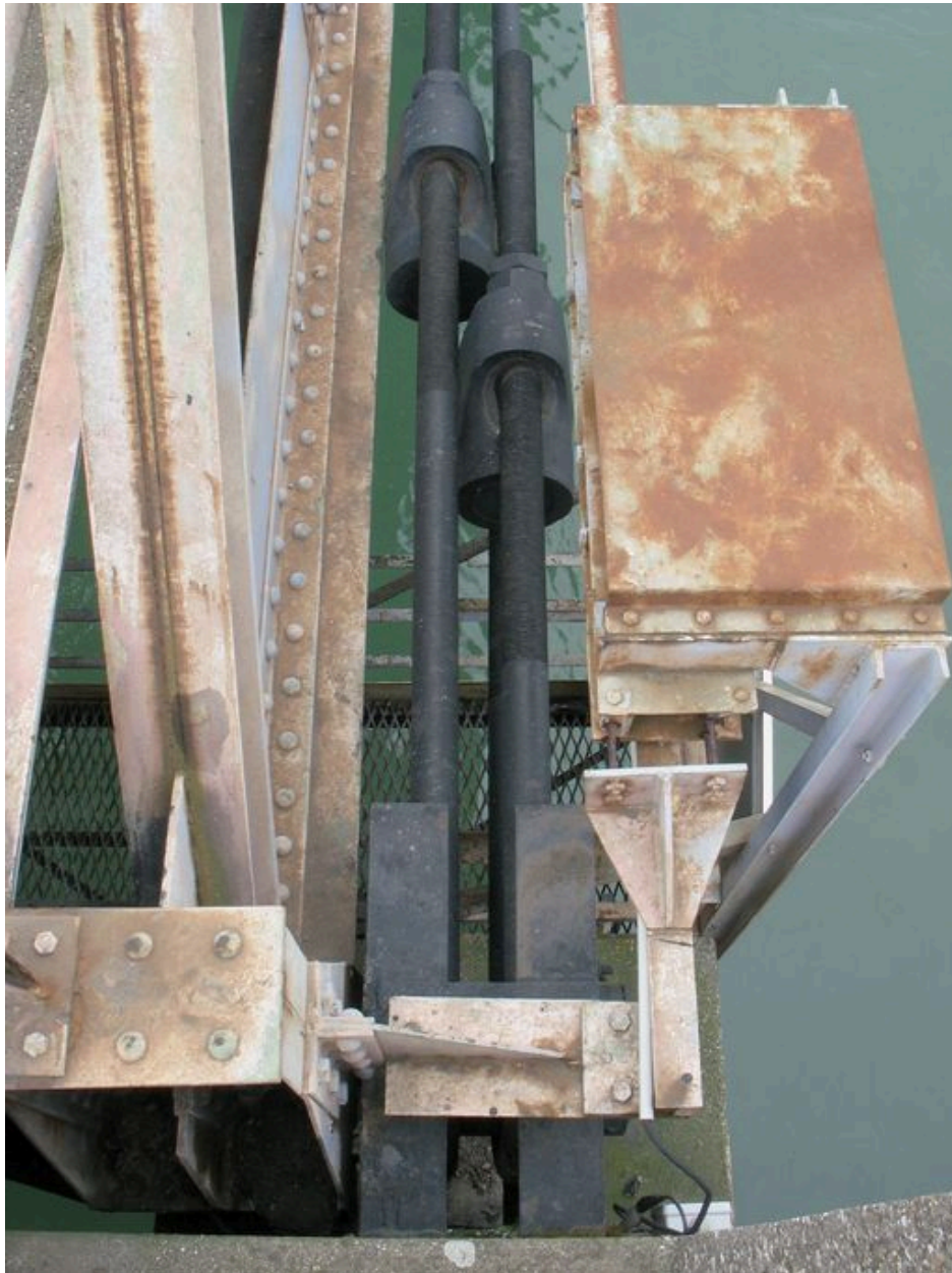
Travée gauche, face amont, vue de détail : ancrage du câble porteur dans la culée, du dessus (depuis la rive gauche)
