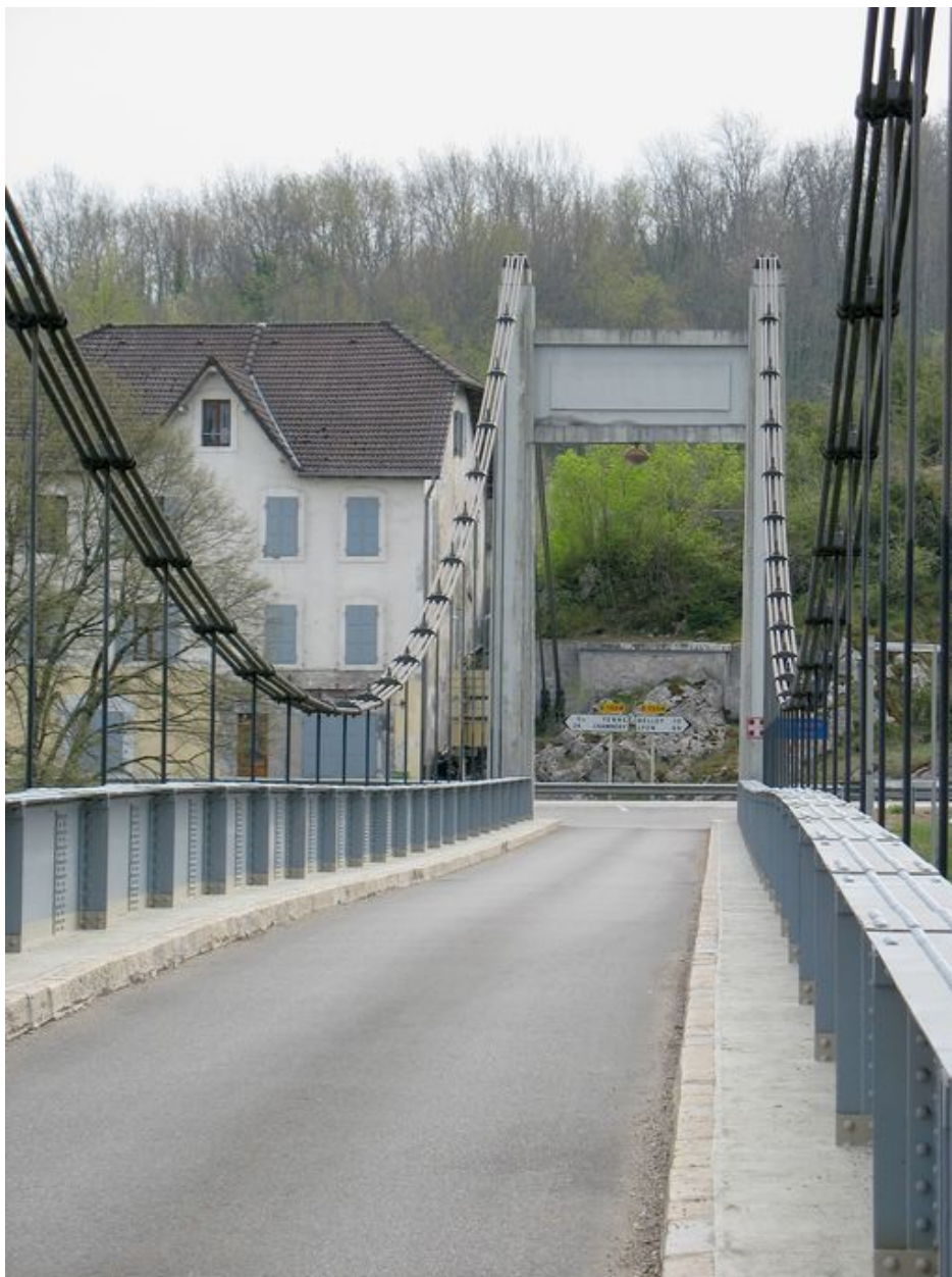
Vue partielle, de dessus, câbles porteurs et suspentes, pylône gauche (depuis la rive droite)
