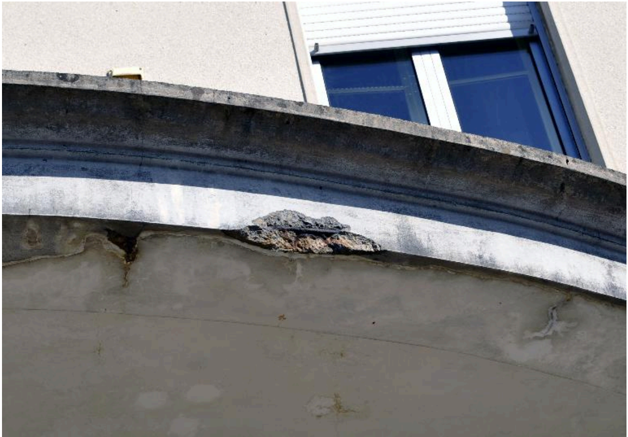
Élévation principale, détail de la marquise
