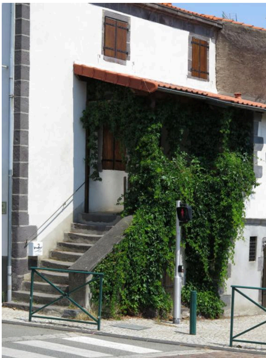
Vue partielle de la façade
