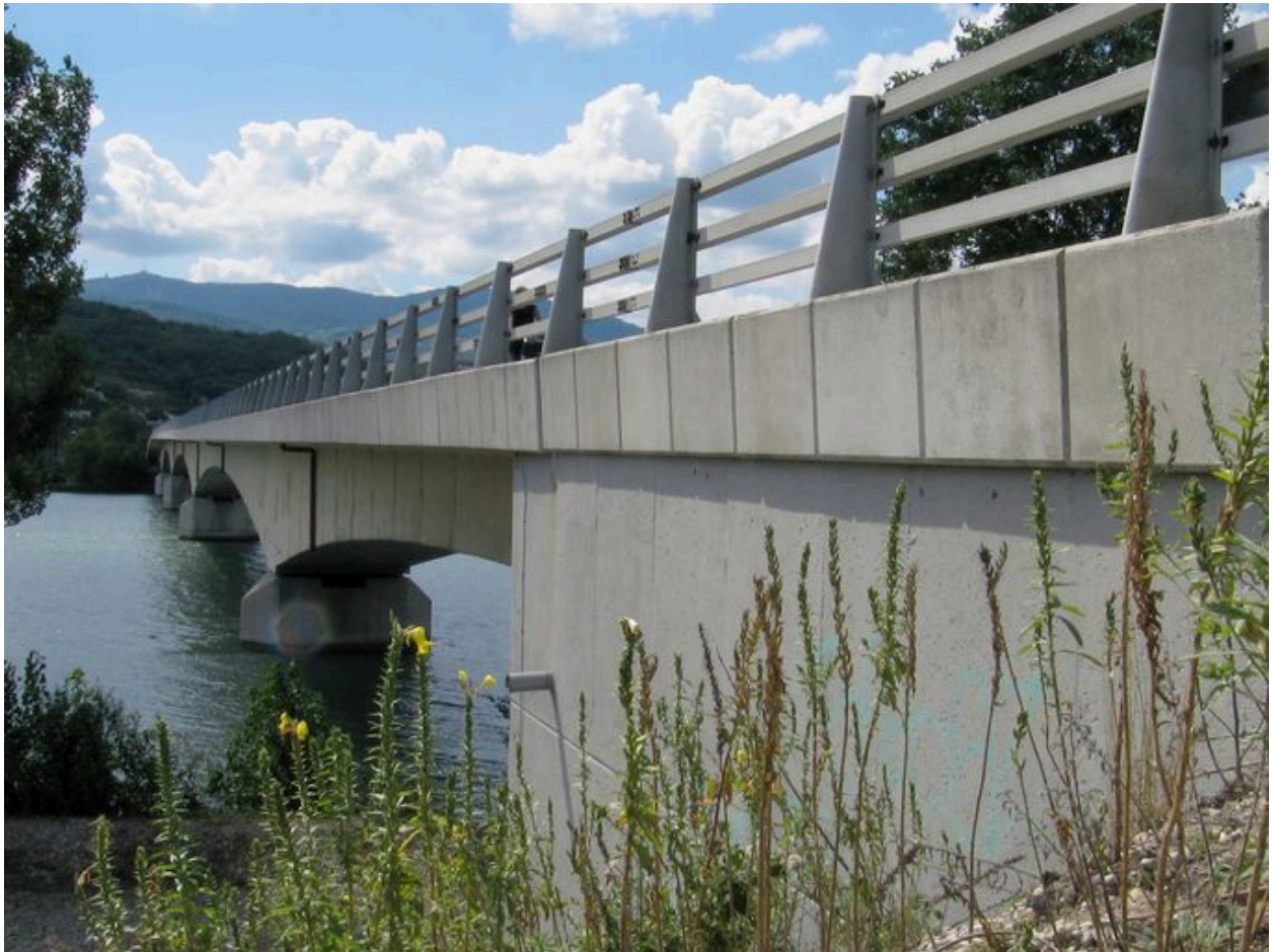
Vue générale, de côté, face aval (depuis la rive gauche)
