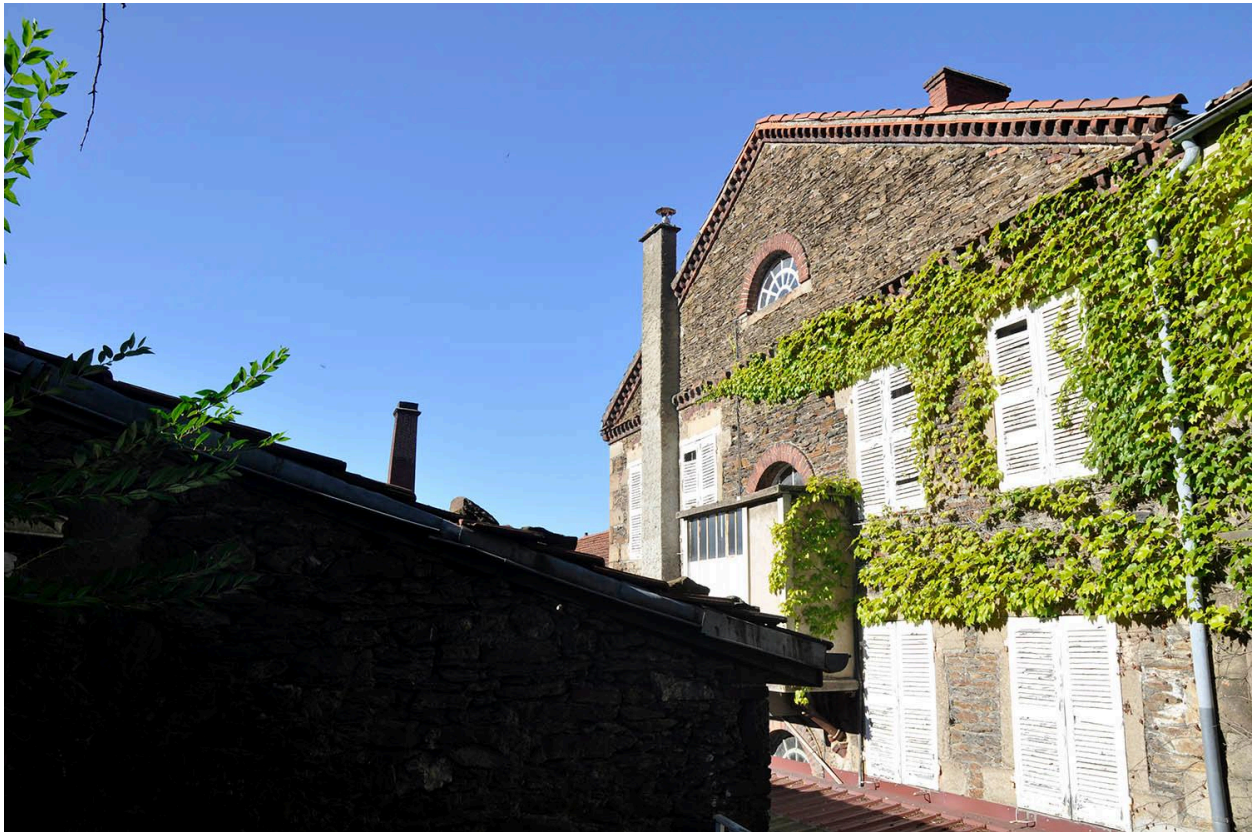
Vue extérieur du bâtiment
