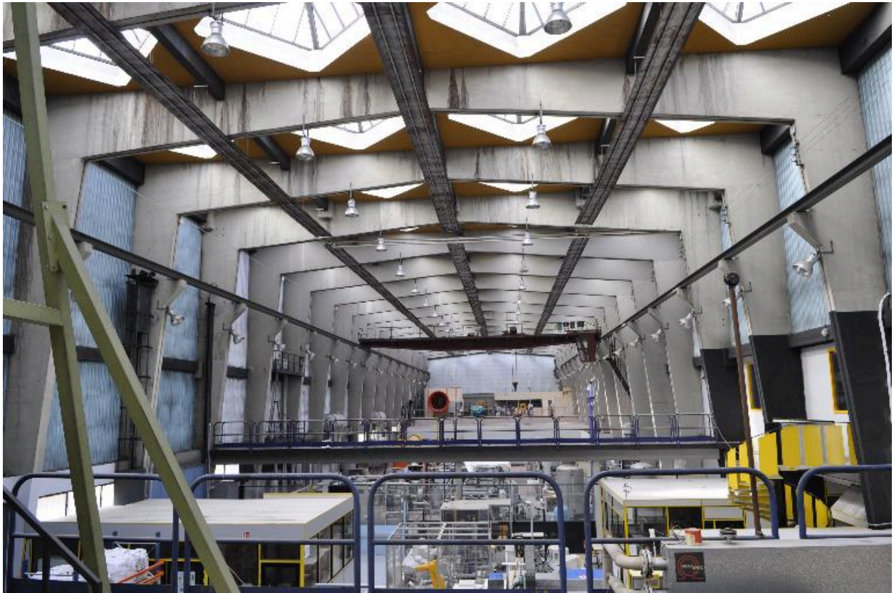
Vue de l'intérieur de la halle
