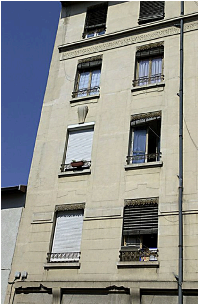
Détail de deux travées de fenêtres
