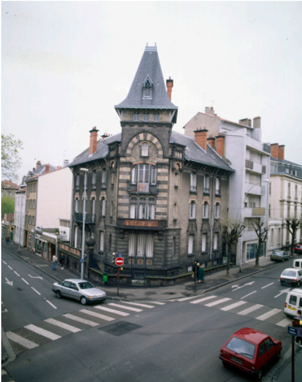
Immeuble, dit villa Giraudon, 27 avenue d'Italie
