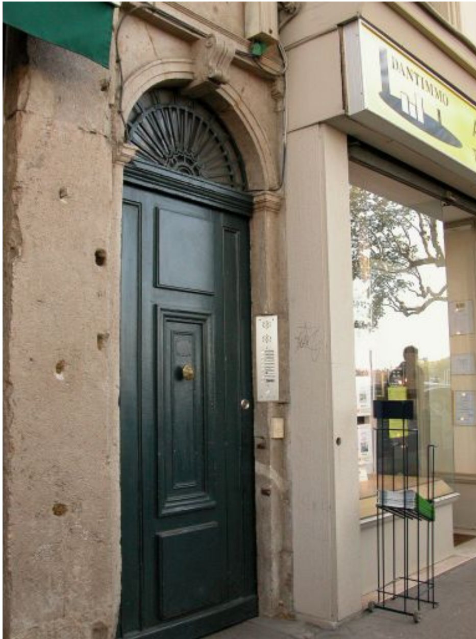
Façade, détail de la porte
