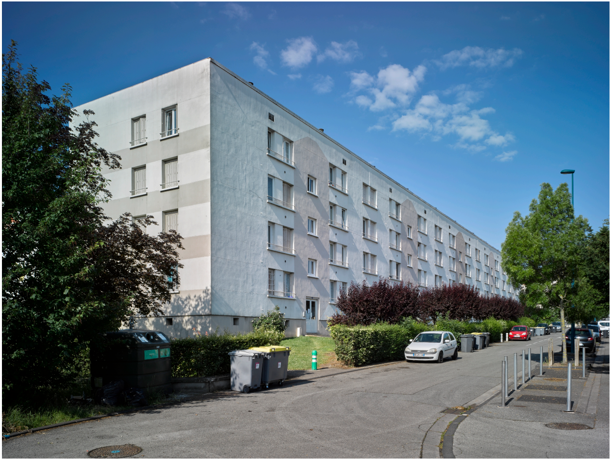
Immeuble collectif n°2 rue de la Fontcimagne, vu depuis le nord-est.
