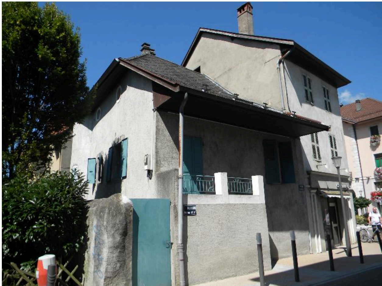
Vue d'ensemble du bâtiment
