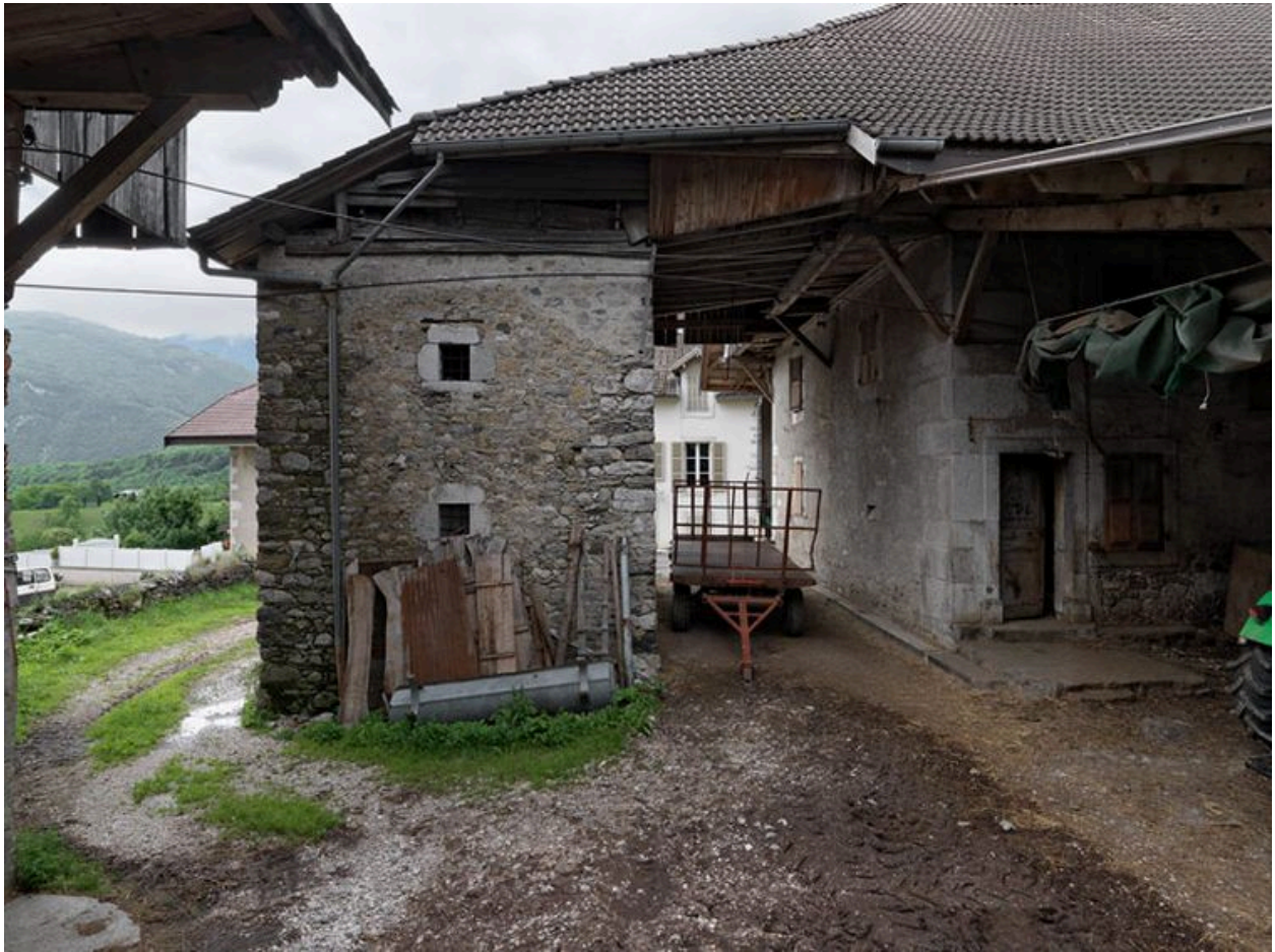
Vue de la façade principale et du bâtiment de dépendance.
