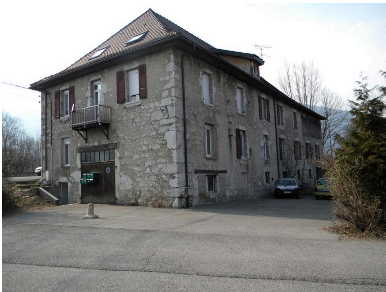
Vue de troisquarts depuis la route de Vieille Eglise.
