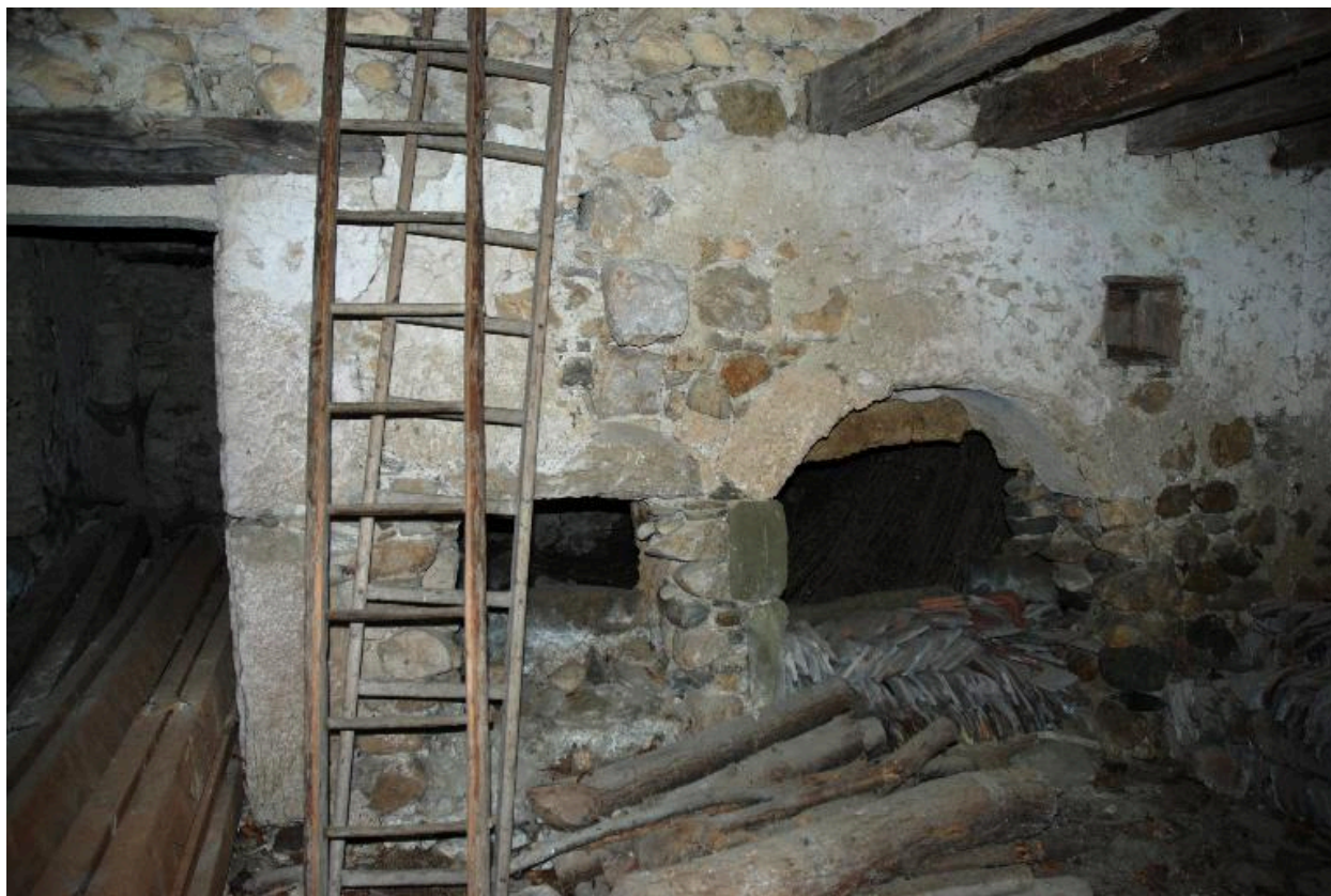
Vue d'ensemble de la première pièce du logis avec ouverture arrière du foyer de la cheminée (ancienne
