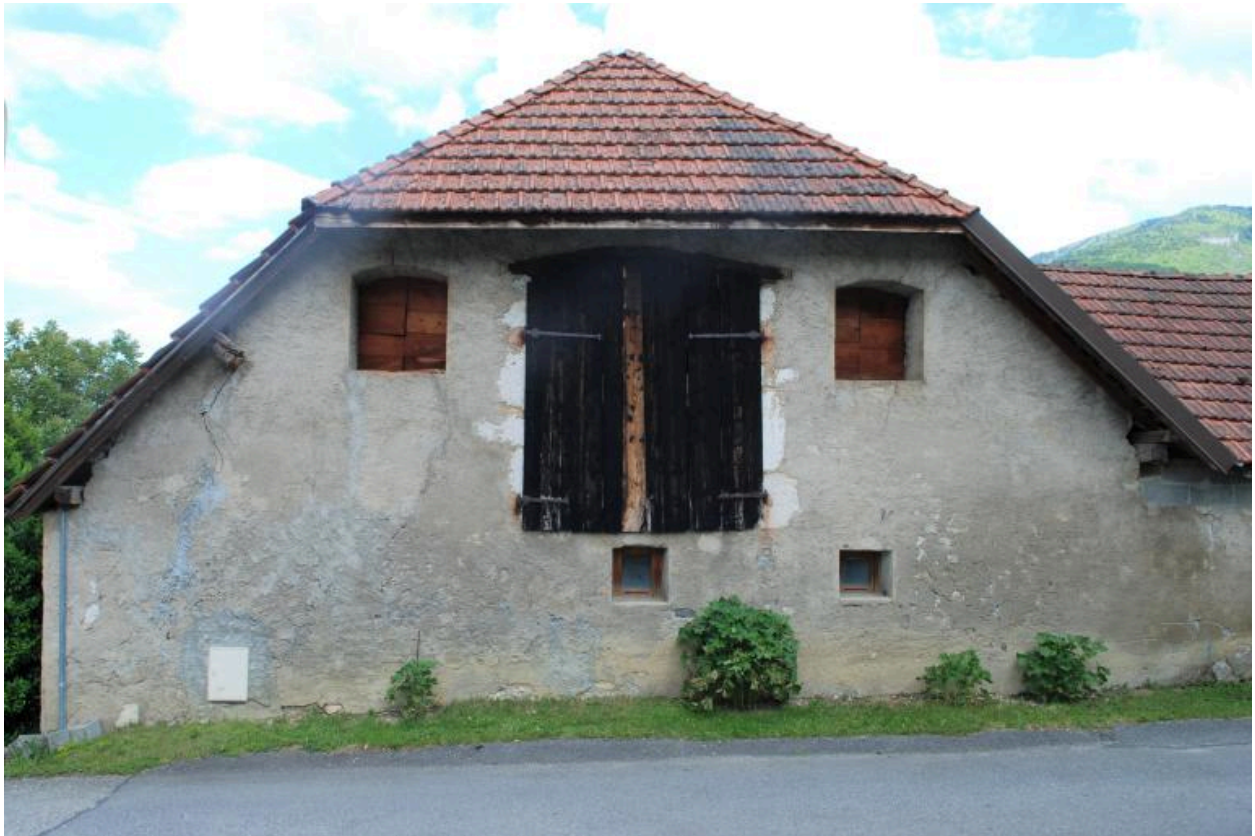
Vue d'ensemble du mur pignon sud.
