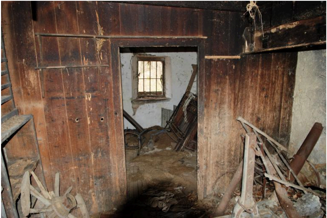
Vue intérieure de la cloison séparant la cuisine de la chambre.
